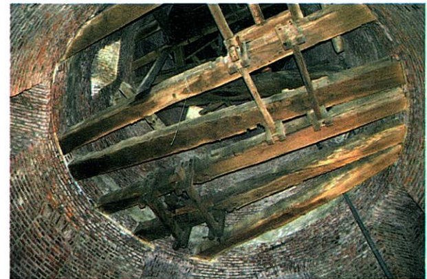
Blick in die Dachhaube
